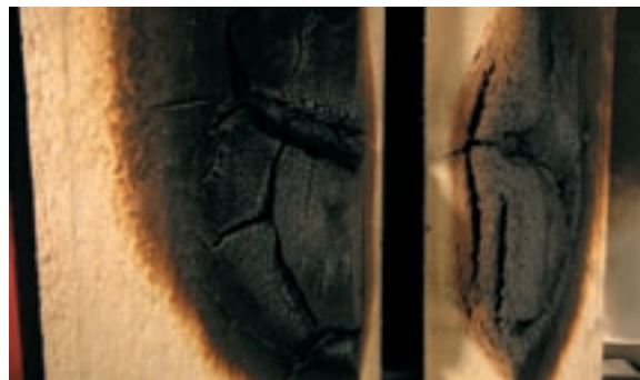
Uhlíkatá vrstva vzniká pouze v oblasti přímého vystavení plameni. Nedochází k šíření požáru.
